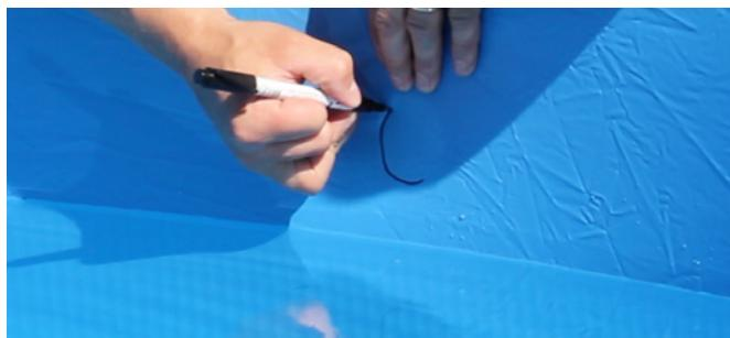
Narysuj/zaznacz okrągły otwór wewnętrznej warstwie basenu, a następnie wytnij krzyżyk w kole za pomocą ostrego noża. (rys. 4). Nie wychodź przy cięciu poza zaznaczony otwór. Załącz odpływ (11) wraz z uszczelką (12) od wewnętrznej strony basenu i przełącz przez ściankę basenu. Zamocuj odpływ do ścianki basenu, dokręcając mocno plastikową nakrętkę (13). Nakrętki nie należy dokręcać ze zbyt dużą siłą.
