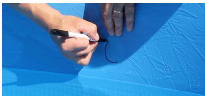
Rita/markera det runda hålet i linern och skär sedan ett kryss i cirkeln med en vass kniv. Skär inte utanför det markerade hålet. Placer nu returloppet (11) och en packning (12) inifrån poolen och ut genom poolväggen. Fäst returloppet till poolväggen genom att skruva plastmuttern (13) ordentligt. Dra inte åt muttern för hårt.
