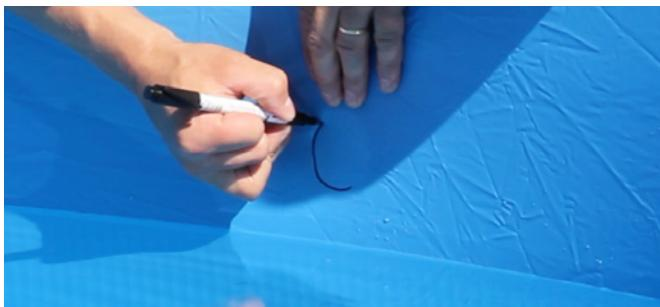
Tasten Sie den Kreis in der Beckenwand ab und machen Sie mit einem scharfen Messer (Stanleymesser) einen Kreuzschnitt, ohne dabei über die Ausstanzung hinauszuschneiden. Stecken Sie die Einlaufdüse(11) mit einer Dichtung (12) von der Beckenwandinnenseite nach außen durch. Verschrauben Sie die Einströmdüse auf der Außenseite mit der Gegenmutter(13).
