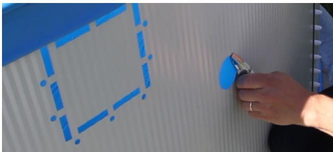
Bassengveggen er klargjort med utstansede hull til respektive skimmer og returløp. Hullene kan klippes eller skjæres til og alle ujevne kanter fjernes med en fil.
