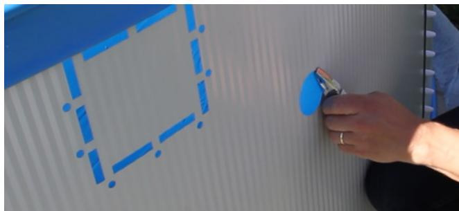
W ściance basenu przygotowano wytrasowane otwory do skimmera i odpływu. Otwór należy wyciąć/dociąć, a wszystkie nierówne krawędzie wyrównać pilnikiem.
