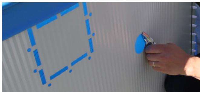
I poolvæggen er der typisk forberedt et hul til hhv. skimmeren og til returløbet. Hullerne skal du skære/klippe fri og dernæst skal alle kanter og grater fjernes med en fil.
