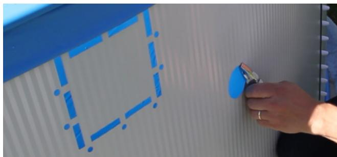
Poolväggen är förberedd med utstansade hål till respektive skimmer och returlopp. Hålen kan klippas/skäras till och sedan skall alla ojämna kanter tas bort med en fil.
