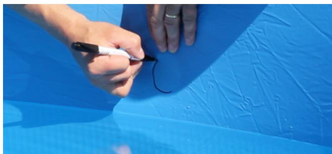
Afmærk den udstansede runde åbning i lineren og **skær dernæst et kryds i cirklen med en skarp hobbykniv**. Undgå at skære ud over kanten. Nu placeres returløbet (11) og en pakning (12) fra poolens inderside og ud gennem poolvæggen. Fastgør returløbet til poolvæggen ved at skru plastomløberen (13) godt fast. Undgå at overspænde omløberen.
